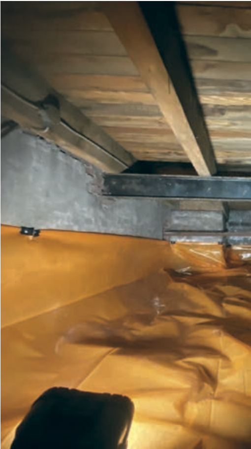
De volgende stap is het afdekken van de bodem van de kruipruimte.
