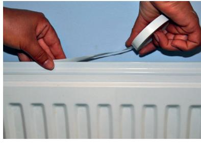
Bevestig de dubbelzijdige tape aan de bovenkant van de radiator.
