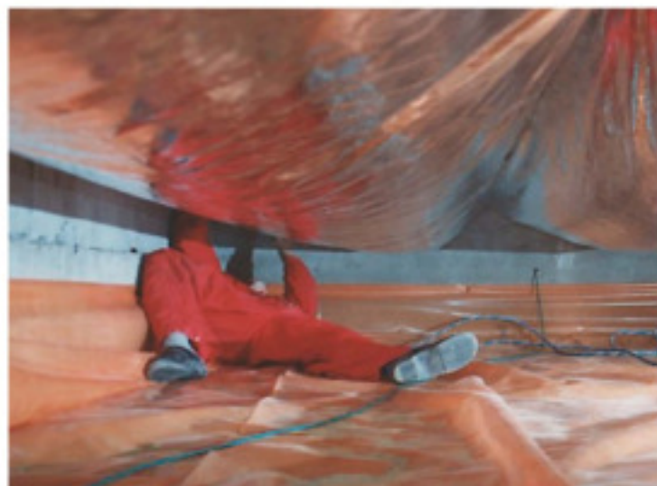
Het aanbrengen van de Tonzon isolatiekussens in de kruipruimte.
